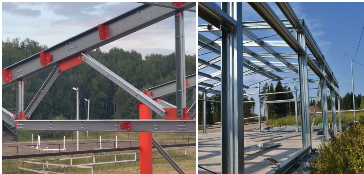
Рис. 1. Примеры применения легких стальных тонкостенных конструкций
