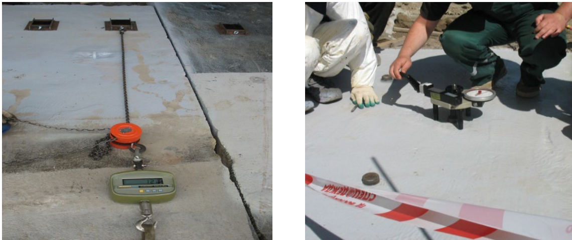
Рис. 6. Испытание гидроизоляции на адгезию (когезионный характер отрыва)
